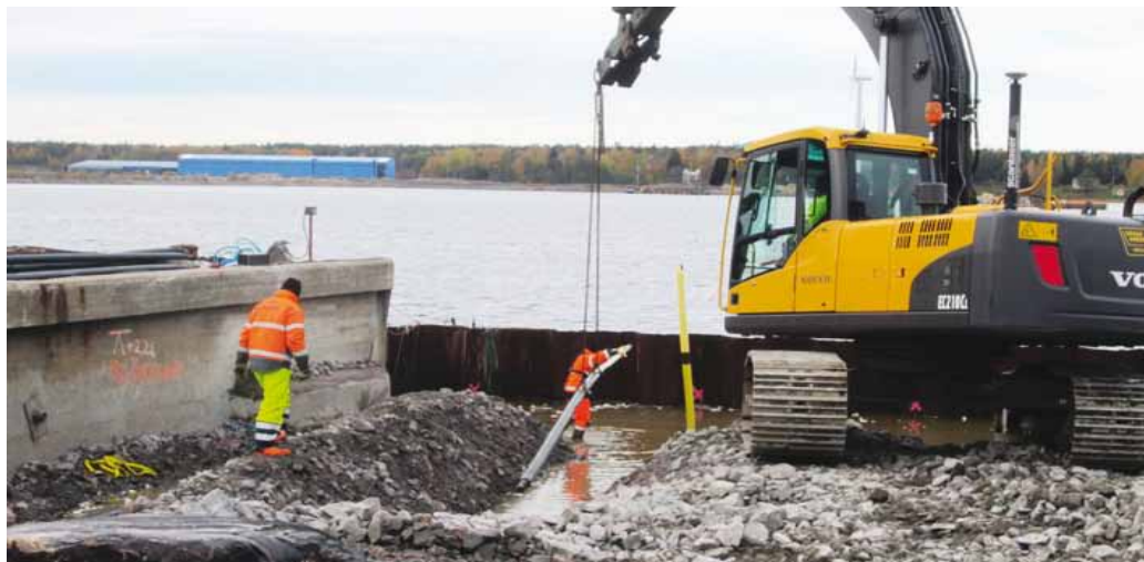
Arbete pågår med pilotförsöket stabilisering av muddermassor med cement, Merit och aska i Gävle hamn.
