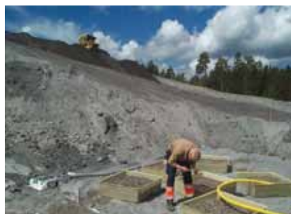
Aska som täckning av deponi på Tvetatippen i Södertälje
