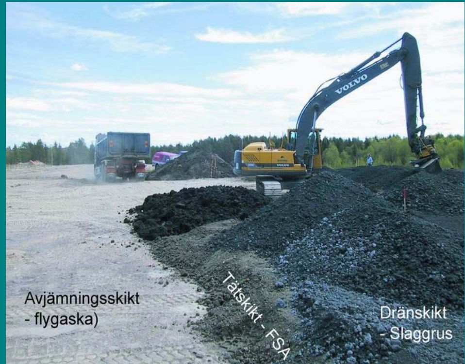
Tättskikt på Dragmossen med 50/50 aska och röttslam (FSA)
