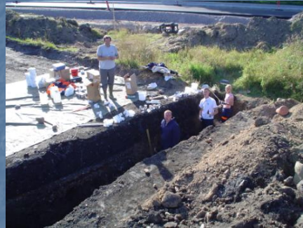
Utgrävning av 18 år gammal väg En av grunderna för beräkning av ringa risk
