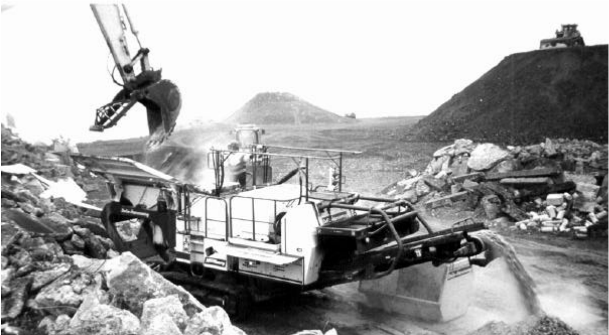
Figur 3.3 Krossning av betong för Törringevägen
