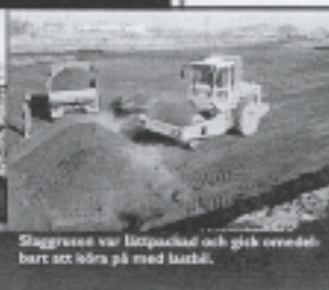
Mixadta bärighetstester följde packningen av slaggruset.
