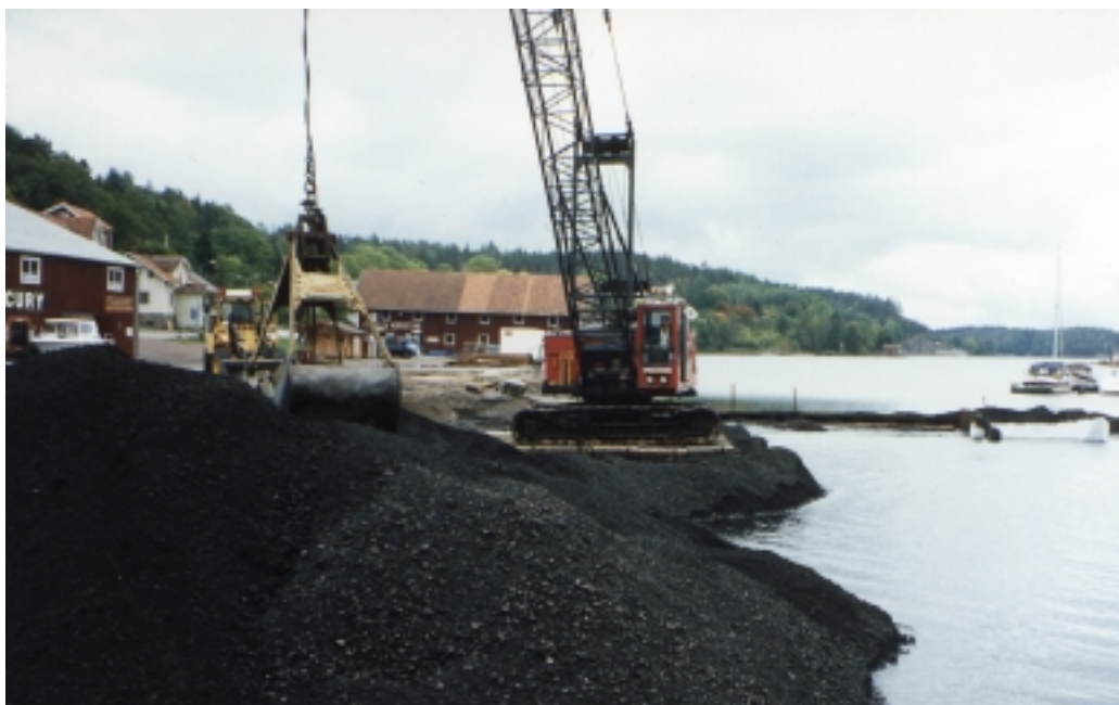
Figur 2.3 Bottenaska från koleldning på rooster används som lättfyllningsmaterial i Valdemarsviks hamn (foto J. Rogbeck).
