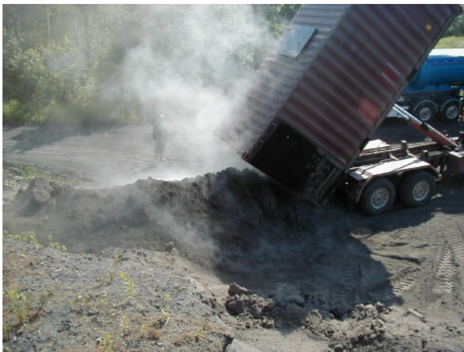
Figur 6-12 Transport av flygaska. Vattenånga avgår efter befuktning.
