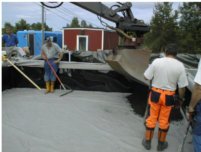
Figur 6-6 Utläggingsarbete i cell A.
